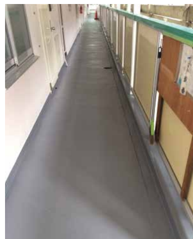
HCスプレー吹付後
