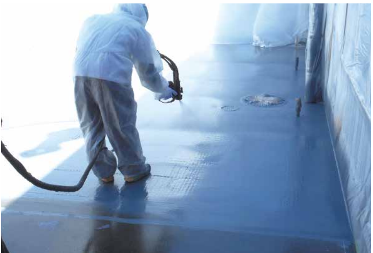
HCスプレー吹付け
