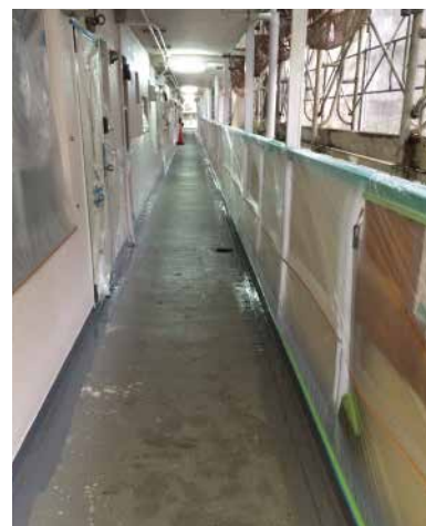
HCスプレー吹付前
